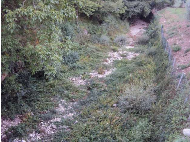
Comune di Buonabitacolo Località Petrale Foto n. 7 Prima LONGITUDINE 15,619835 LATITUDINE 40,266585 V.04.010.100.b - Ripristino funzionalità di valloni
