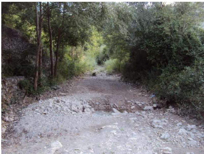
Comune di Casalbuono Località Ponte del Re Foto n. II Prima LONGITUDINE 15,701001 LATITUDINE 40,194164 V.04.010.100.b - Ripristino funzionalità di valloni
