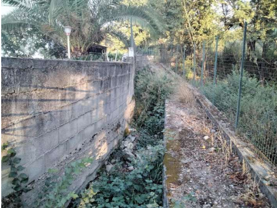
V.04.010.100.b - Ripristino funzionalità di valloni
