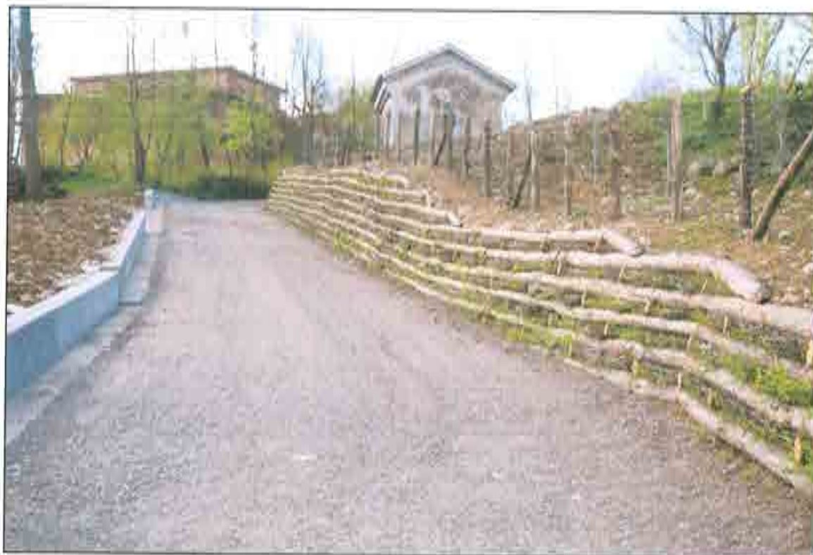
Figura 6 - Pallificata e zanella per sistemazione viaria – Buonabitacolo
