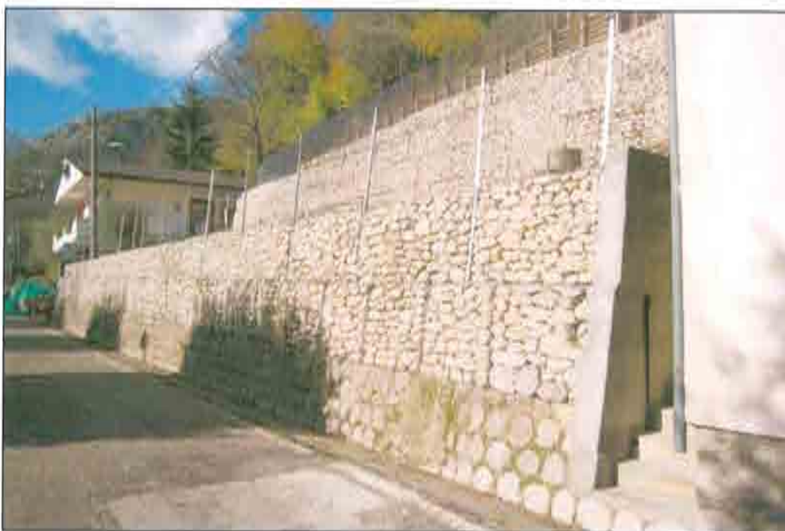
Figura 7 – Gabbionate e palizzate per sistemazione di versante - San Rufo
