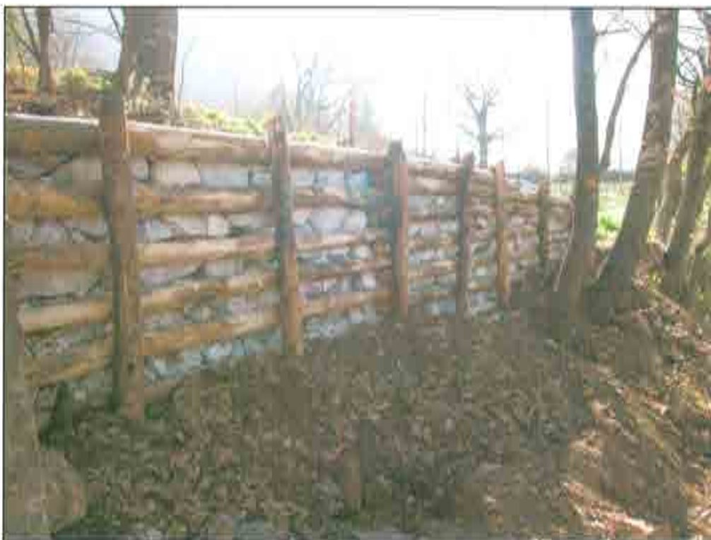
Figura 18 – Sistemazione scarpata stradale - Padula
