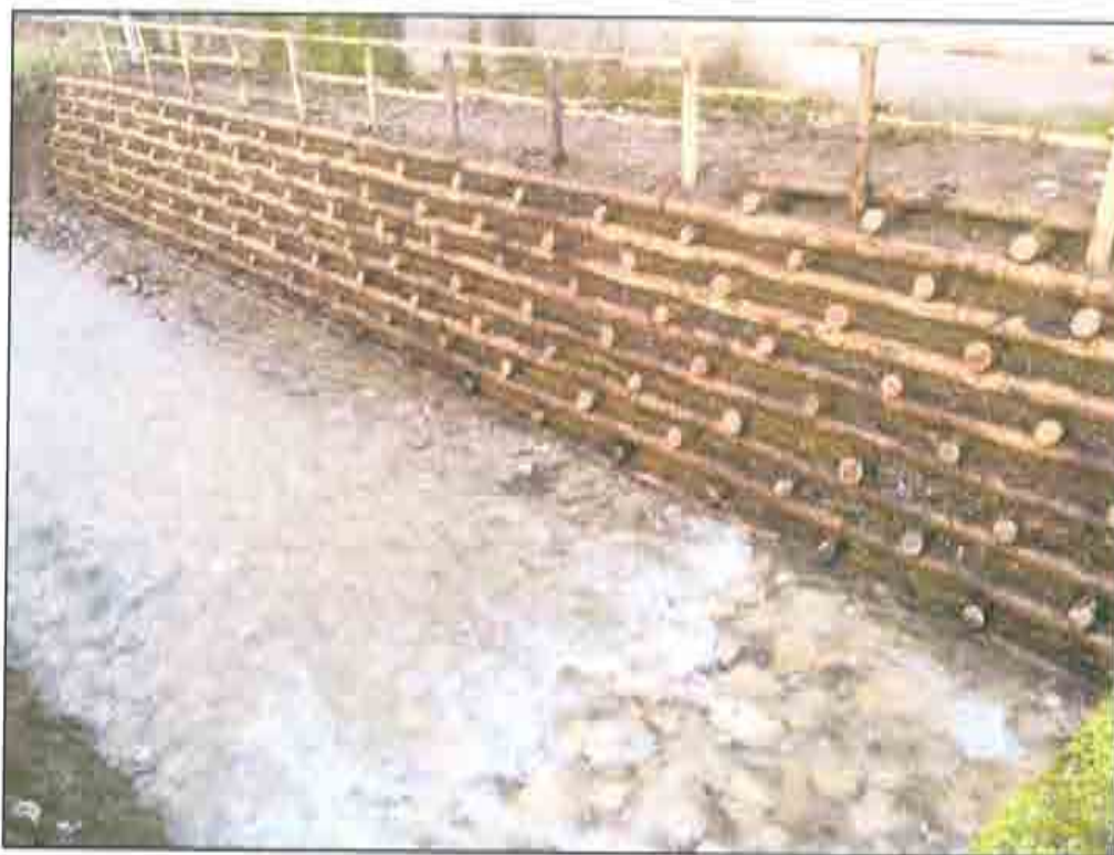
Figura 1 – Palficata spondale Torrente Setone – San Pietro al Tanagro
