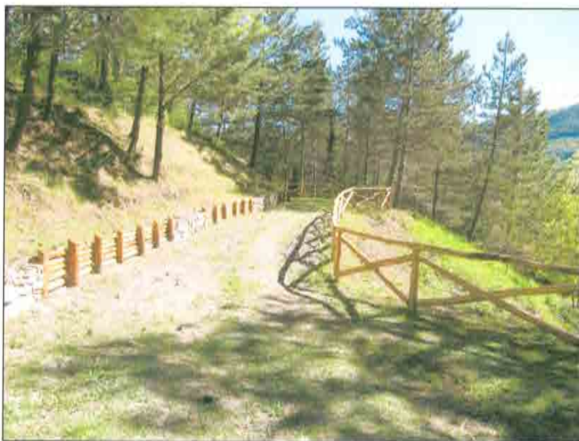
Figura 8 – Muri a secco, palizzate e staccionate - Casalbuono
