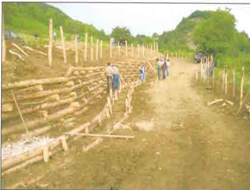
Figura 9 - Palificata per sistemazione viaria San Rufo
