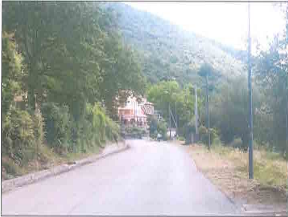
Figura 16 - Manutenzione Strada provinciale - SP 18 Sanza-Rofrano
