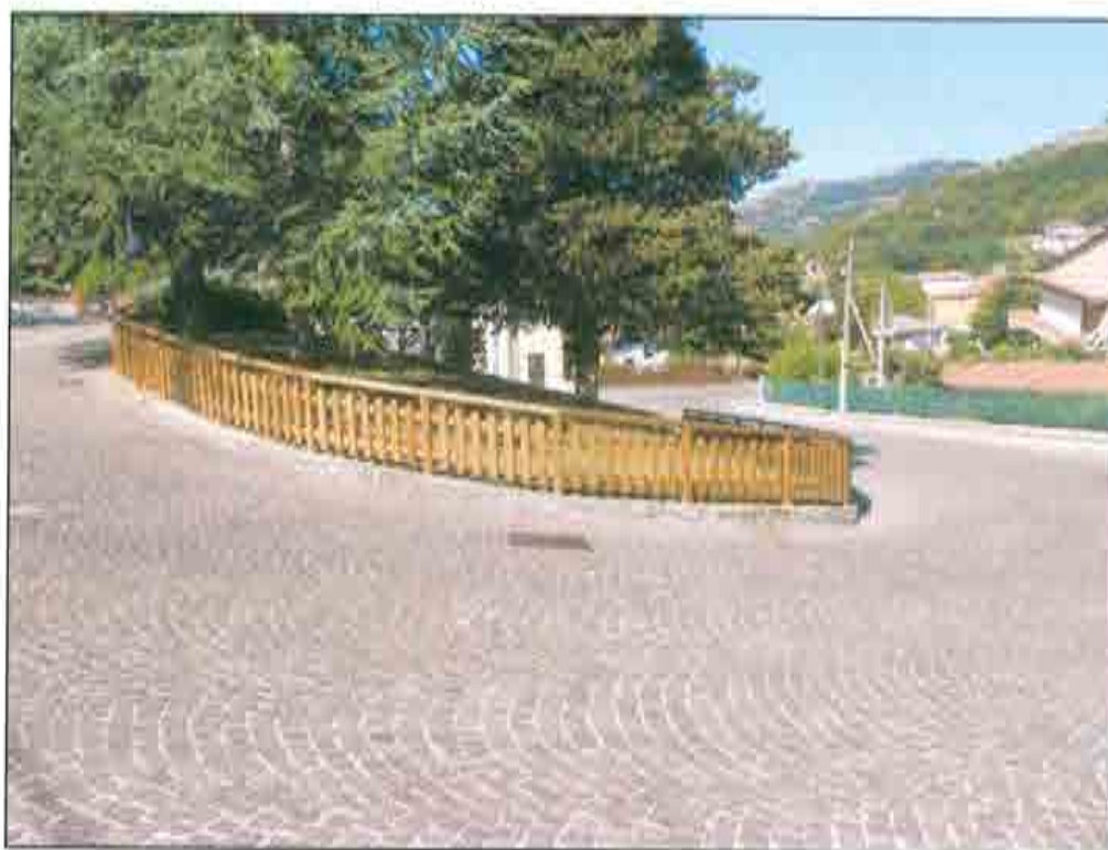
Figura 41 - Ringhiera con legno piallato in area verde - Buonabitacolo
