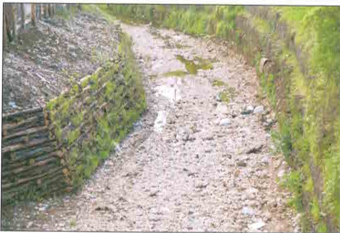
Figura 5 - Pallificata a doppia parete Torrente Peglio – Buonabitacolo
