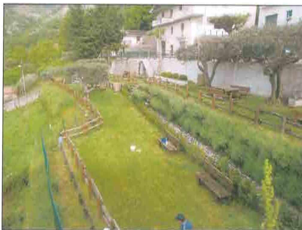
Figura 52 - Realizzazione area verde - San Rufo
