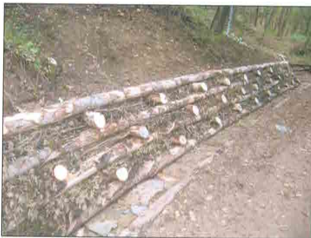
Figura 2 - Palficata per sistemazione e mantenimento del versante – San Pietro al Tanagro
