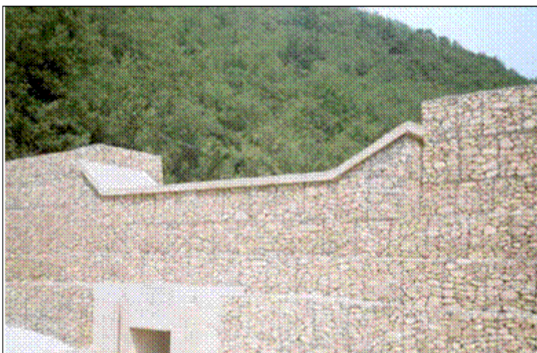
Figura n.5 – Esempio di briglia in gabbioni
